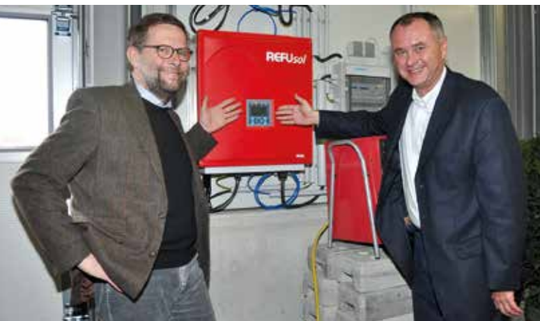
Die Photovoltaik-Anlage am Dach der neuen Halle des Mödlinger Wirtschaftshofes liefert seit Herbst 2013 sauberen und umweltfreundlichen Strom.
