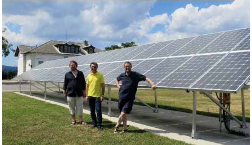
Am Areal der Mödlinger Kläranlage wird eine große Photovoltaik-Anlage errichtet. BürgerInnen haben die Möglichkeit, sich daran zu beteiligen.
