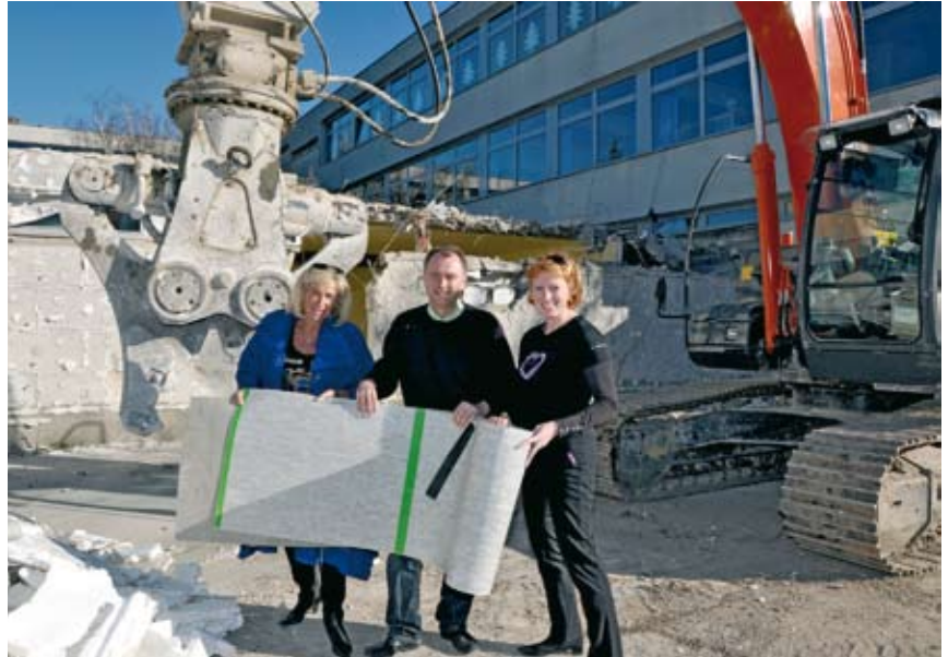
Bild oben: Dir. Sabine Karl-Moldan, Bürgermeister Hans Stefan Hintner und GR Maria Hintner (v.l.) mit einem Teil des alten Hallenbelages. Im Hintergrund sind die Abbrucharbeiten bereits in vollem Gang.
